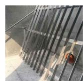
Grigliatura in acciaio inox AISI 304 a barre verticali di luce idonea, realizzata su misura
